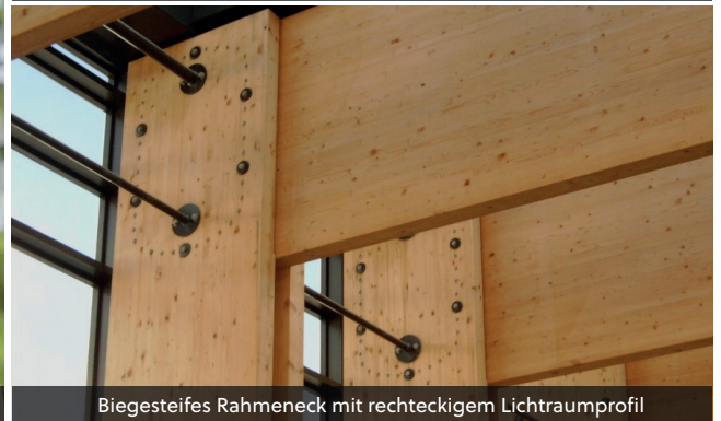
Zweiteiliger Stiel, zweireihiger Dübelkreis mit Vordach
