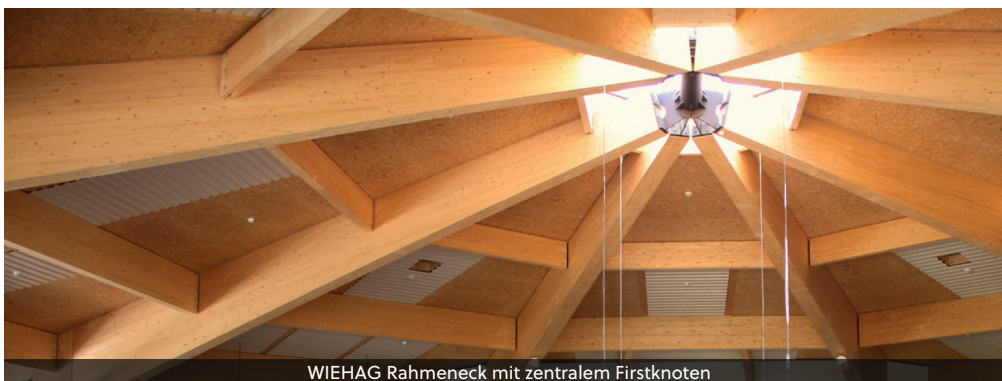
WIEHAG Rahmeneck mit zentralem Firstknoten
