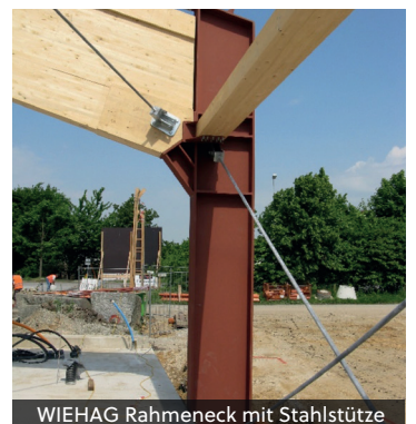
WIEHAG Rahmeneck mit Stahlstütze
